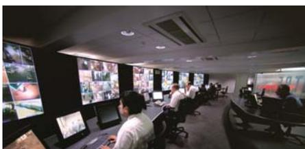
**Notruf- und Service-Leitstelle** zur Überwachung von Alarm-, Störungs- und Statusmeldungen rund um Brandschutz- und Sicherheitstechnik sowie sonstiger kritischer Bedingungen (Überflutung, Temperatur). Unsere VdS- sowie TÜV Service-zertifizierte Notruf- und Service-Leitstelle erfüllt strengste Standards und komplexeste Anforderungen. Zudem bieten wir umfassenden Service im Bereich des Aufzugsnotrufs.
